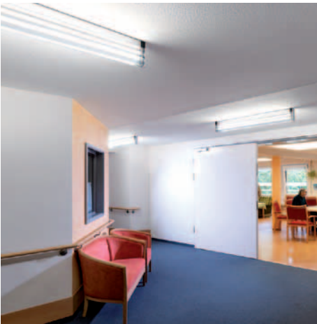
Gut gelöst: Durch eine spezielle Anordnung der Deckenleuchten wird jeder Winkel ausgeleuchtet
